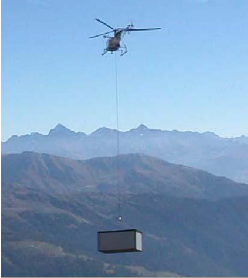
Elicottero che trasporta attrezzature di cantiere
